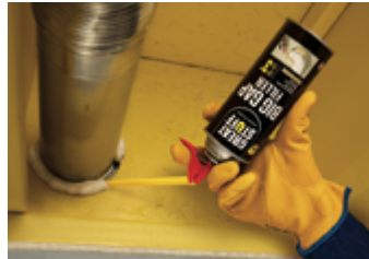
Espacios de difícil alcance
