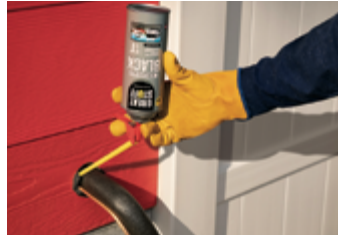
En torno de sistemas de ventilación y calefacción
