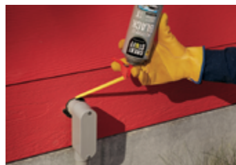
Autour des lignes électriques
