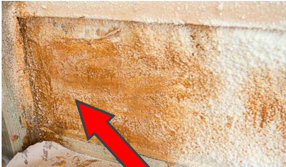
Resultado de un mezclado deficiente y de los tanques medio vacíos: La espuma es muy gomosa y no se cura o está friable (crujiente) y se descascara de la superficie.
