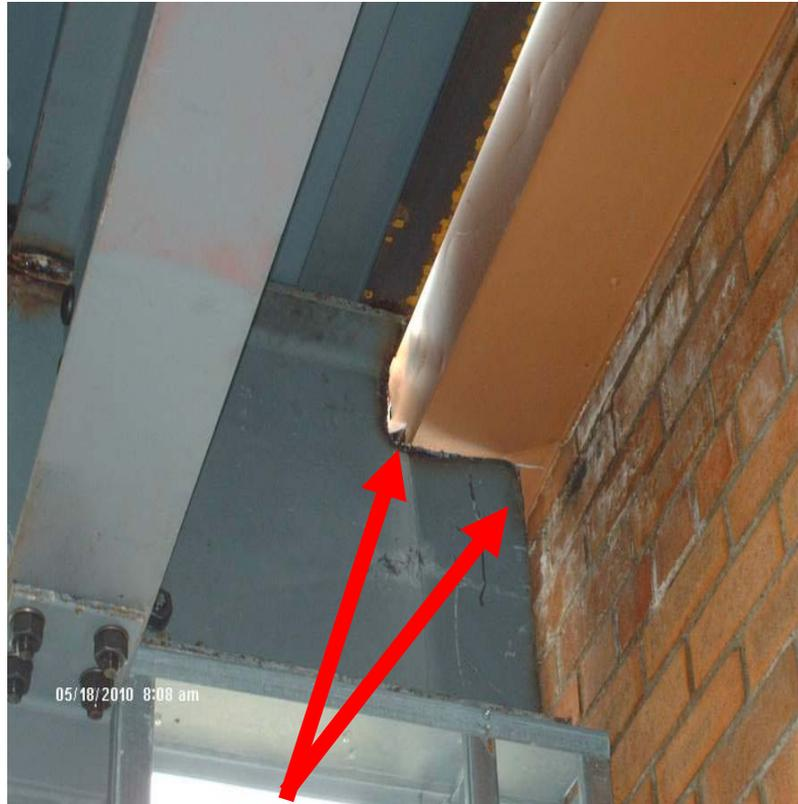
**Debe sellarse la penetración de aire del hueco entre la plataforma y la viga.**
