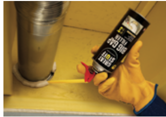
Espacios de difícil alcance
