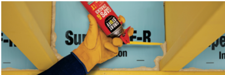
Penetraciones de tuberías
