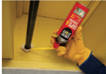
Penetraciones de tuberías
