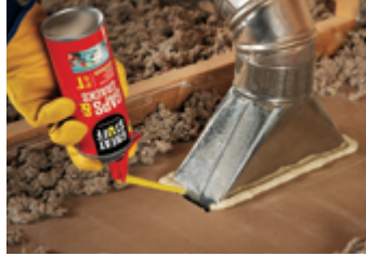
Penetraciones del ático
