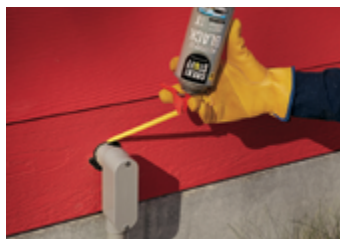
Autour des lignes électriques
